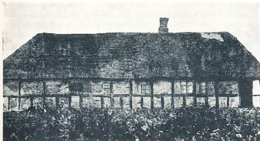
Det oprindelige stuehus til mtr. nr. 18 i Havredal. (Ca. 1908.)
